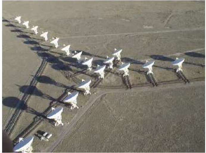
Рис. 12: Very Large Array (VLA) – радиоинтерферометр из 27 полноповоротных 25-м телескопов (США)
